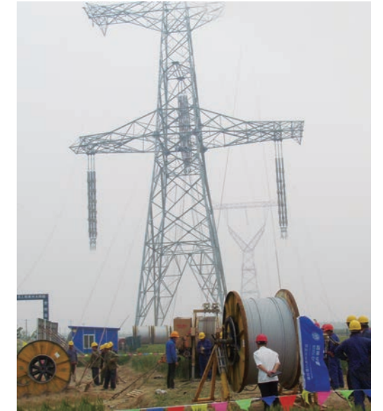
OPGW cable Laying
